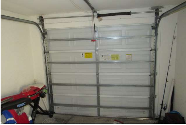
Inside Garage Door
