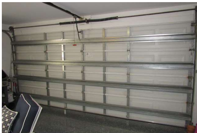
Inside Garage Door
