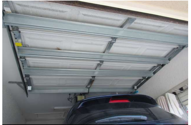
Inside Garage Door
