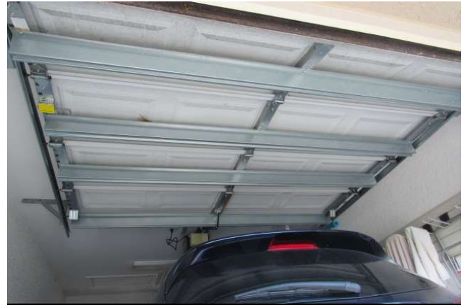
Inside Garage Door
